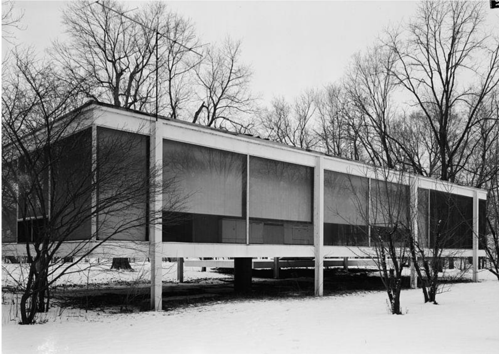
Mies van der Rohe Farnsworth House
